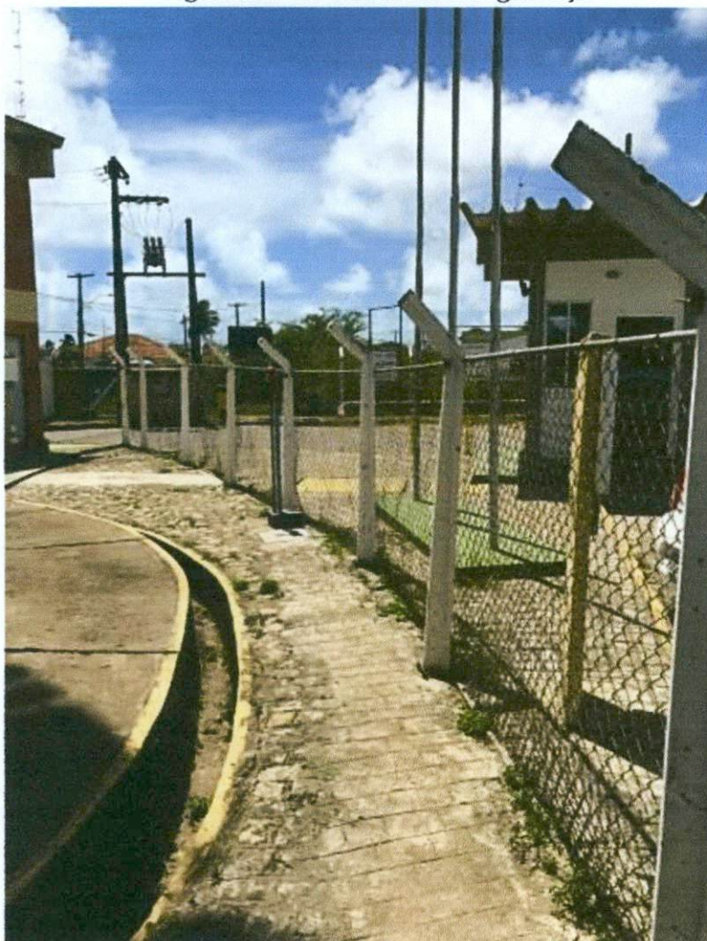
Figura 23 – Cercamento e Segurança
