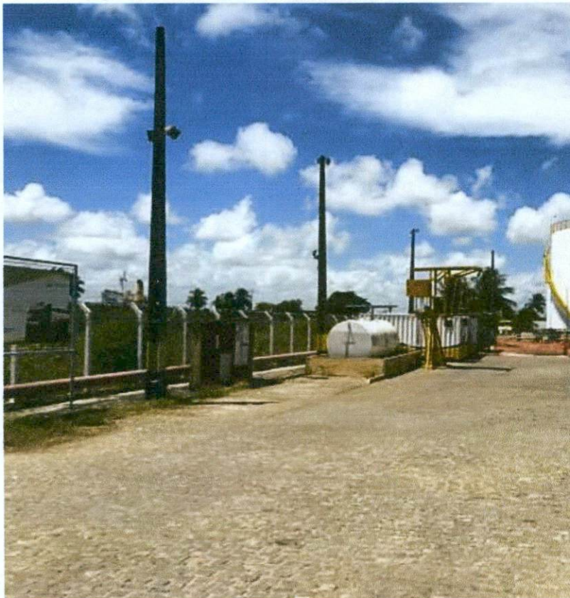
Figura 21 – Distribuição Elétrica e Iluminação
