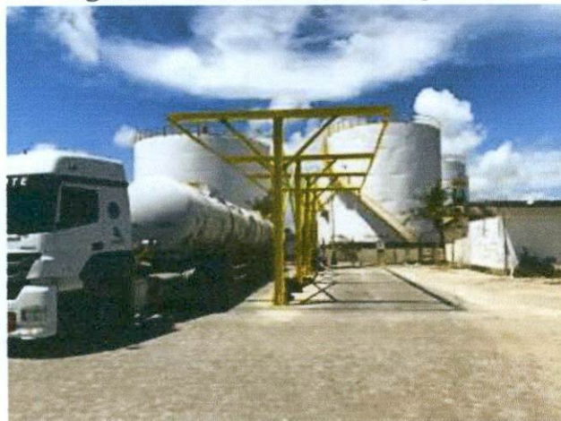
Figura 5 – Plataforma de Carregamento
