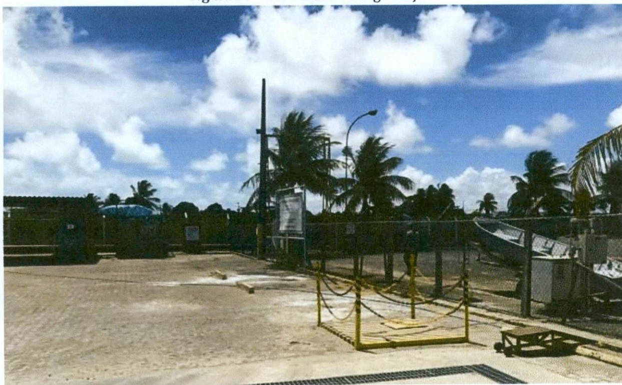
Figura 24 – Cercamento e Segurança
